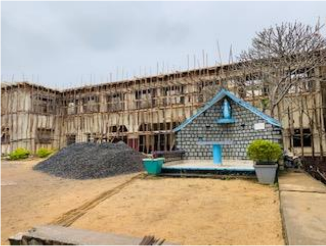
Réfection de la maison des soeurs
